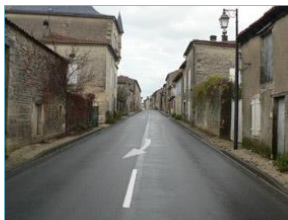
Traversée du Bourg par la RD 736
