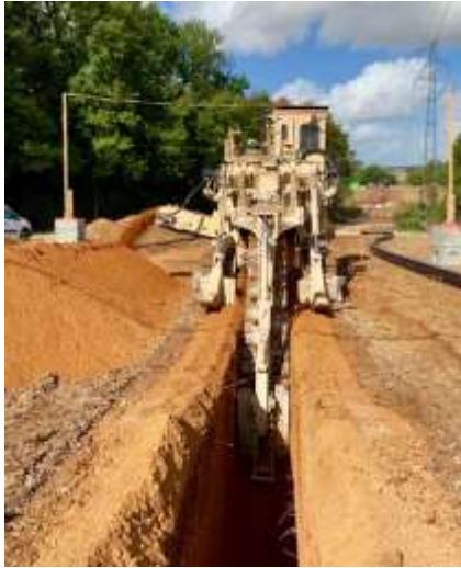
Figure 28 : ouverture de fouille
