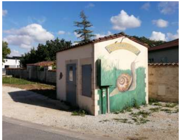
Figure 26: transformateur passant l'électricité moyenne tension (20kV) à basse tension – ligne enterrée à Aigre
