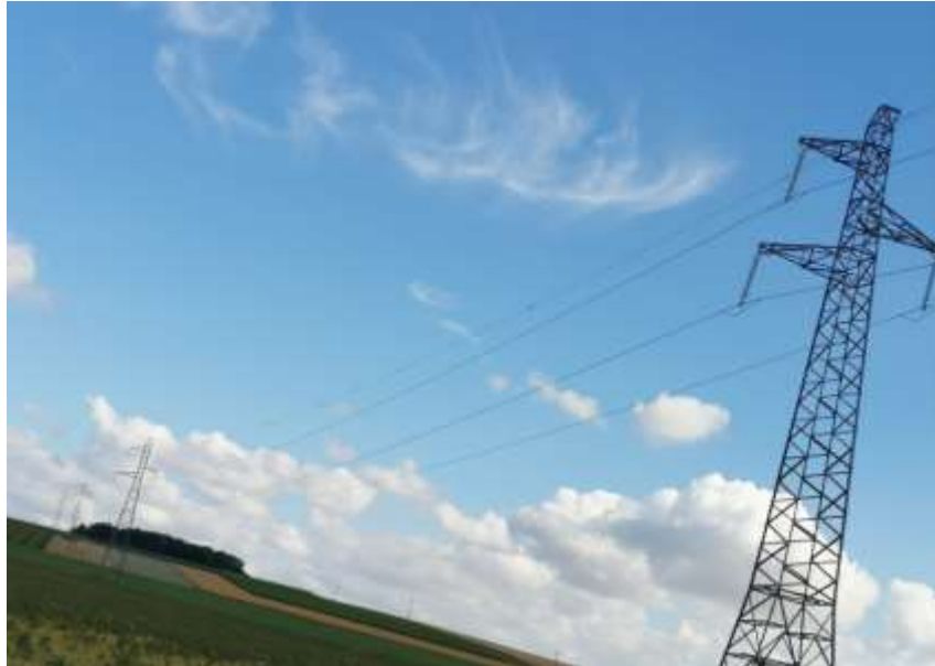
Figure 25: ligne 225kV entre Niort et Fléac à proximité d'Oradour
