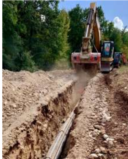
Figure 31: remblaiement
