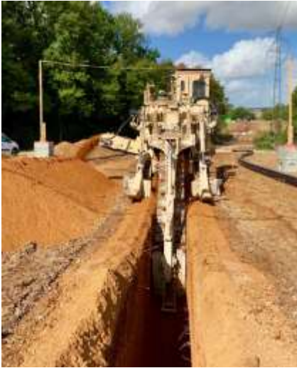
Figure 28 : ouverture de fouille
